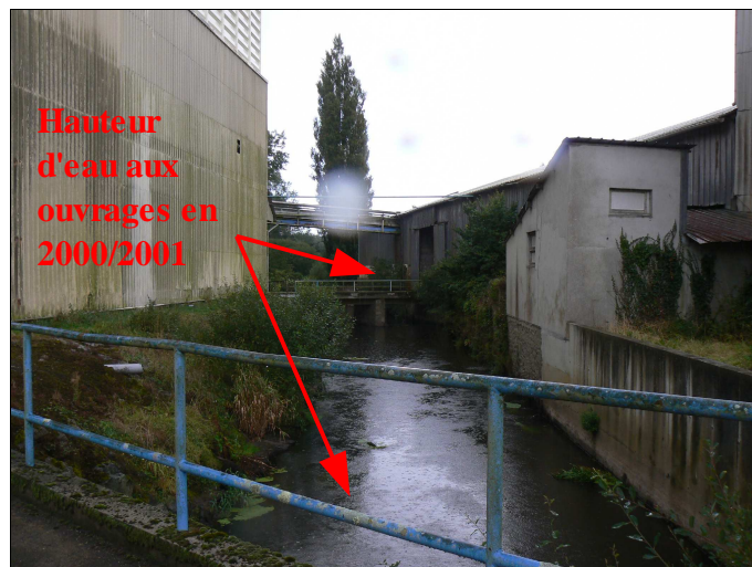
Photo 05 - Premiers barreaux des ouvrages submergés en 2000/2001
